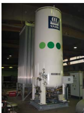
Рис. 2. Система с резервуаром CO 2 низкого давления, испарителем и распределительной станцией на цементном заводе Bamburi компании Lafarge в Кении
