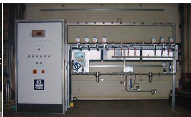
Рис. 2. Система с резервуаром CO 2 низкого давления, испарителем и распределительной станцией на цементном заводе Bamburi компании Lafarge в Кении
