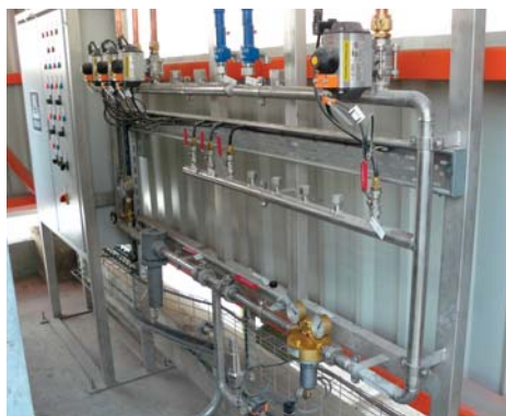
Рис. 3. Система с баллонами N_2 высокого давления и с распределительной станцией на цементном заводе компании Lafarge в г. Резина, Молдова
