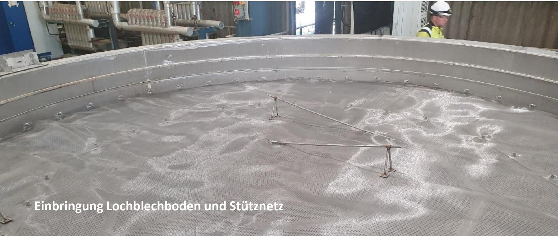
Einbringung Lochblechboden und Stütznetz
